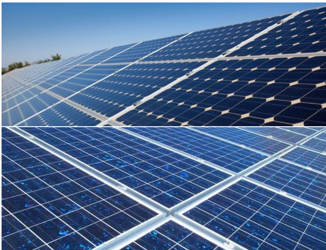
Fig. 3.9. Panouri fotovoltaice monocristaline (sus) și policristaline (jos)
